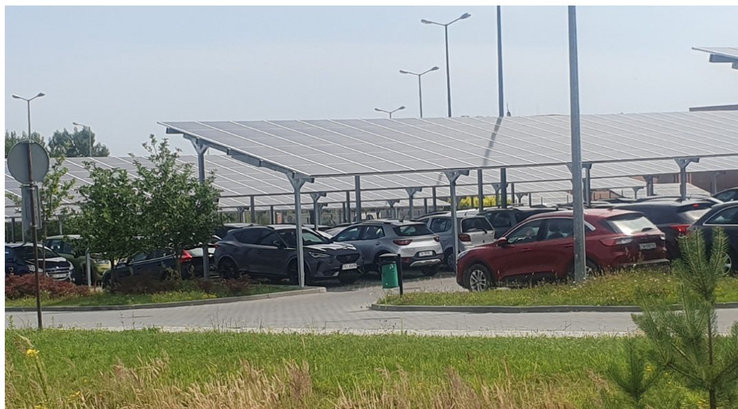
Ryc. 4.3 Przykład łączenia funkcji infrastruktury w mieście – zastosowanie paneli fotowoltaicznych do zacienienia parkingu w Kielcach
