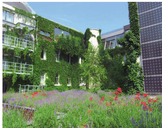
Ryc. 5.5 Przykład błękitno-zielonej infrastruktury w przestrzeni miejskiej – zeroemisyjny Boutique Hotel Stadthalle w Wiedniu
