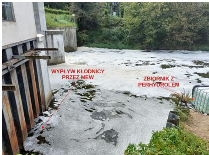
Fot. I.7. Wypływ wody z MEW (stanowisko K2) - praca MEW przy przepływie górnym (przelew przez jaz) (fot. Ł. Weber, 25.08.2024 r.).
