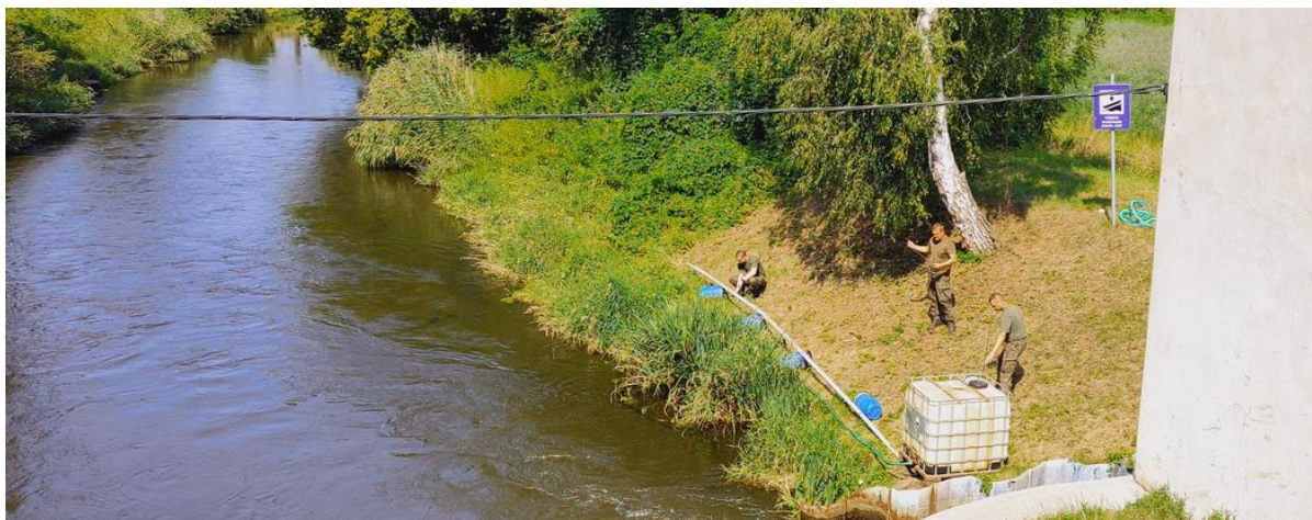
Fot. I.4. Montaż zbiornika ruchomego i dyszy dozującej na brzegu rzeki Kłodnicy, na dolnej wodzie MEW w Pławniowicach. Zdjęcie z działań przygotowawczych (fot. Ł. Weber, 26.07.2024 r.).
