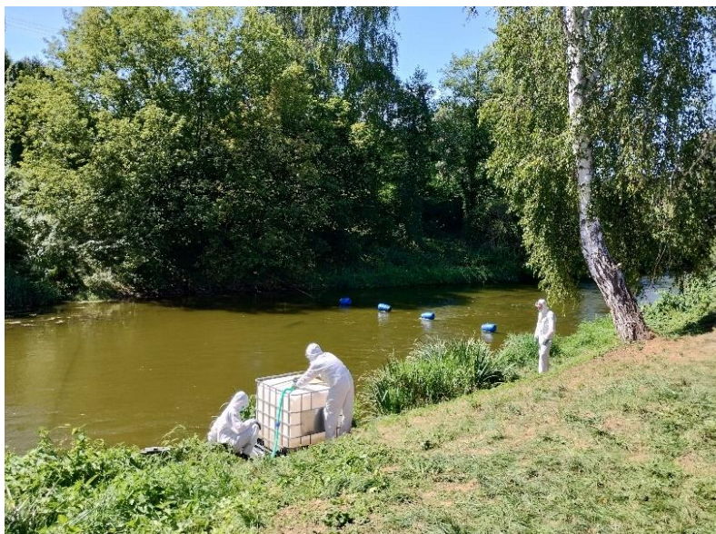
Fot. I.5. Montaż instalacji do dozowania perhydroflu na MEW w Pławniowicach – woda dolna (fot. A. Pasztaleniec, 13.08.2024 r.).
