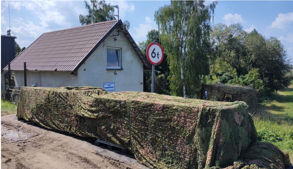
Fot. I.8. Zbiorniki magazynowe rozmieszczone nad punktem dozowania, zabezpieczone przed wpływem światła słonecznego (fot. Ł. Weber, 13.08.2024 r.).
