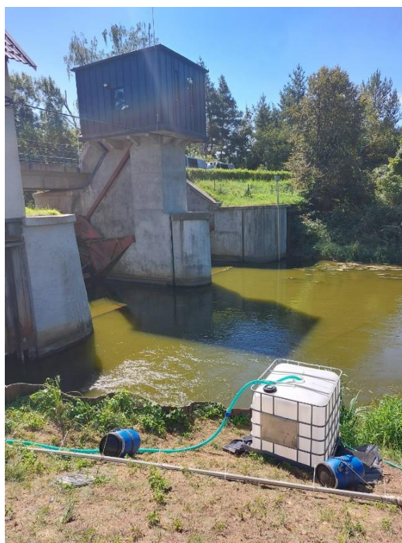
Fot. I.5. Montaż instalacji do dozowania perhydroflu na MEW w Pławniowicach – woda dolna (fot. A. Pasztaleniec, 13.08.2024 r.).
