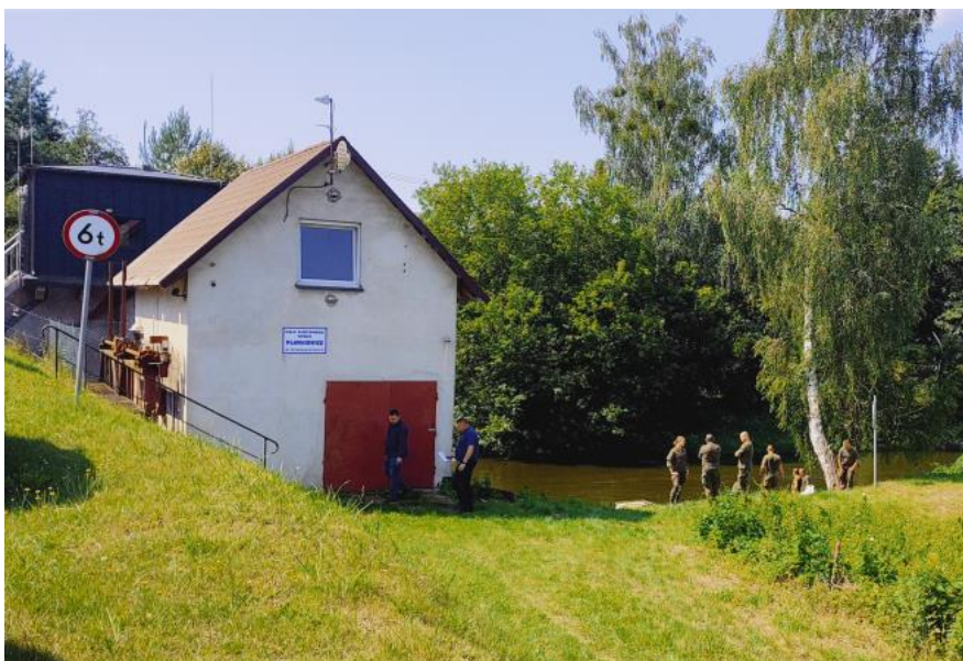
Fot. I.1. Mała Elektrownia Wodna w Pławniowicach. Miejsce przeprowadzenia testów. Zdjęcie z działań przygotowawczych (fot. Ł. Weber, 26.07.2024 r.).
