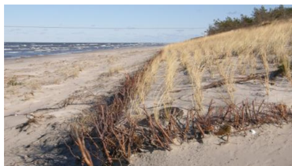
Rys. 83. Sztuczna vegetacja na odbudowanej wydmie, Lubiatowo Fot. G. Różycki Źródło: https://klimada2.ios.gov.pl/katalog-dobrych-praktyk-adaptacyjnych/
