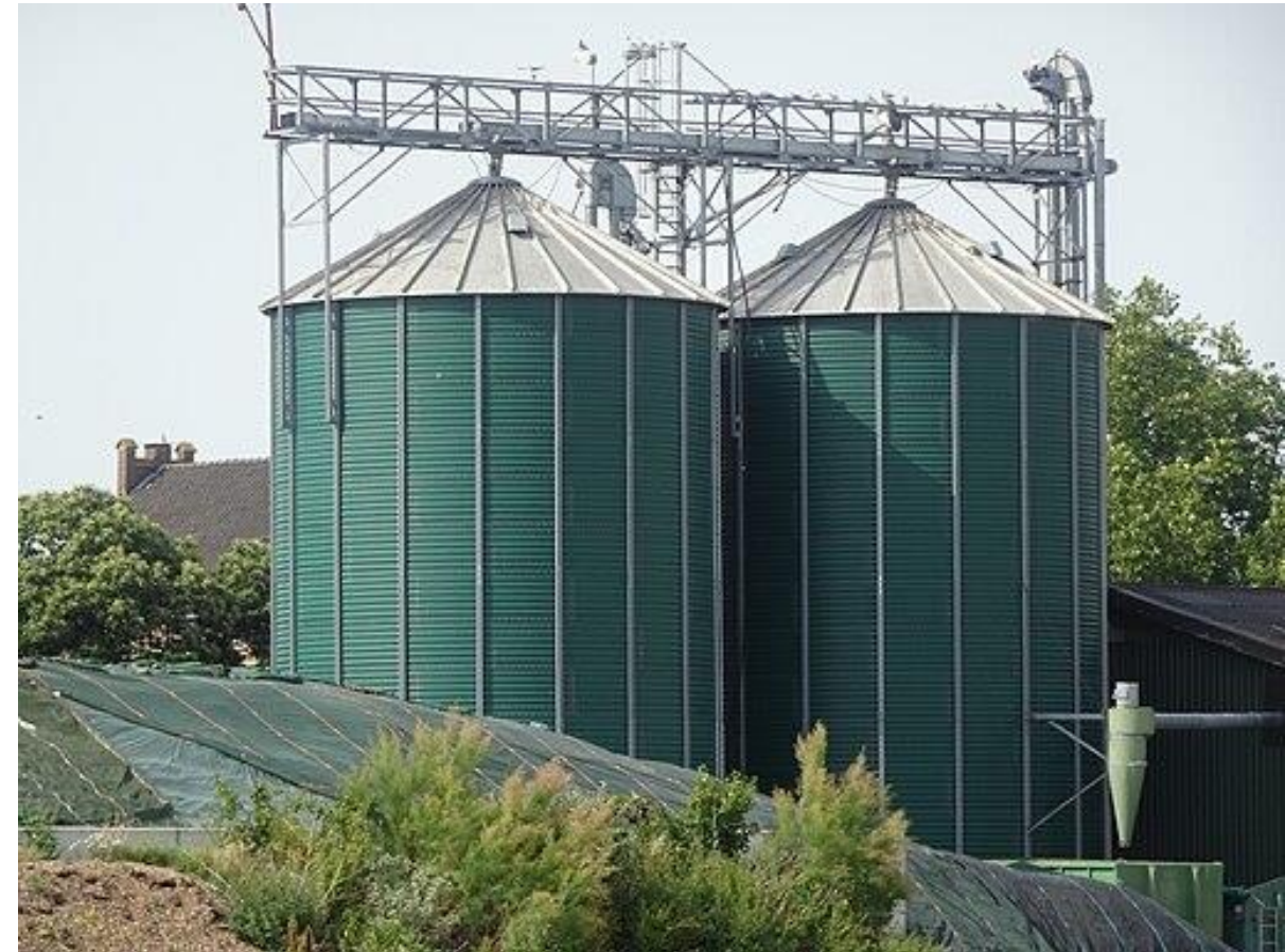
Komory fermentacyjne biogazowni w Kleve, Niderlandy Źródło: Pieter Delicaat; Wikimedia Commons
