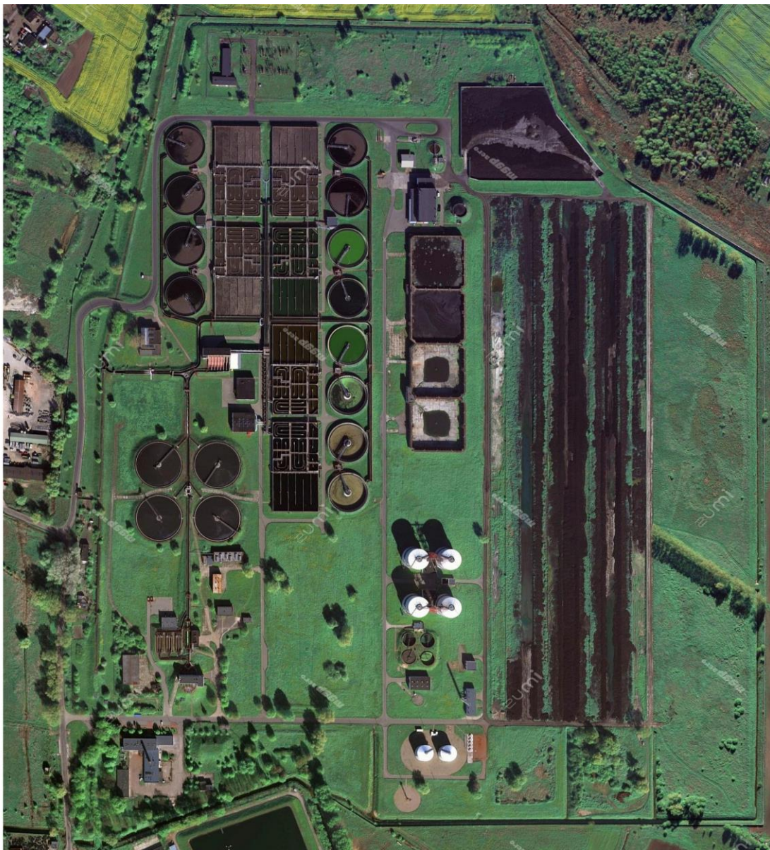
Obiekty na terenie Oczyszczalni Ścieków Gdańsk Wschód. Źródło: https://www.giwk.pl/infrastruktura/elementy-infrastruktury/elektrociepownia-biogazowa/#gallery-11
