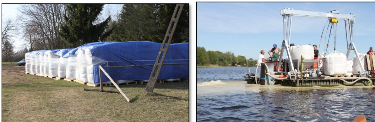
Rys. 2. Glinka bentonitowa modyfikowana lantanem w ilości 300 ton zmagazynowana nad brzegiem Jeziora Gołdap (lewy panel) oraz specjalistyczny sprzęt pływający do aplikacji tego preparatu
