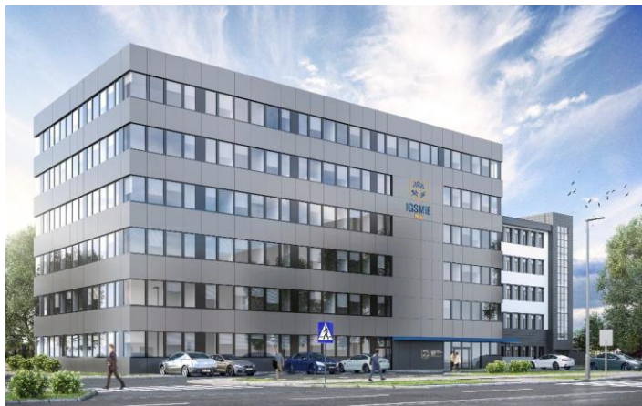
Powstający nowy budynek IGSMiE PAN w Krakowie
